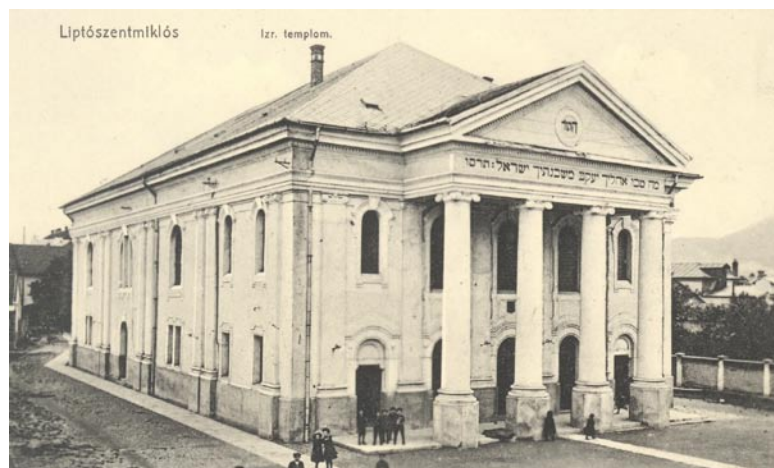
Pohľad na synagógu po Baumhornovej prestavbe z roku 1906.
