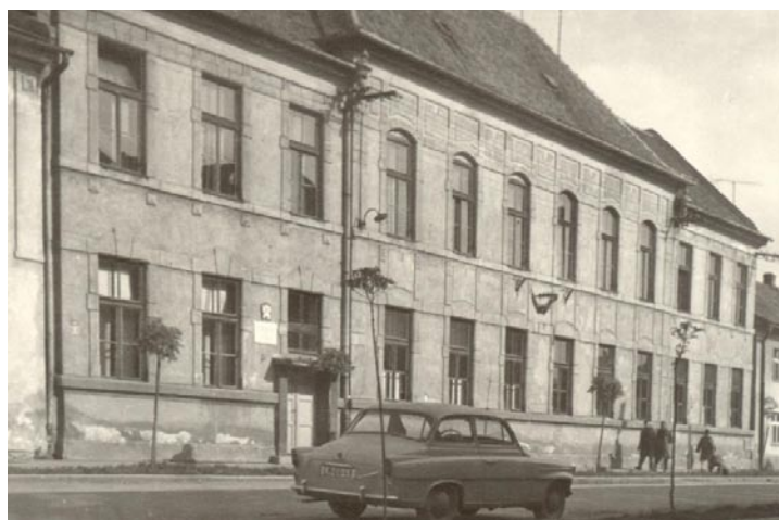
Dnes už nestojaca budova niekdajšej židovskej ľudovej školy. Po druhej svetovej vojne sa do jej priestorov presťahovala liptovskomikulášska učňovská škola.
