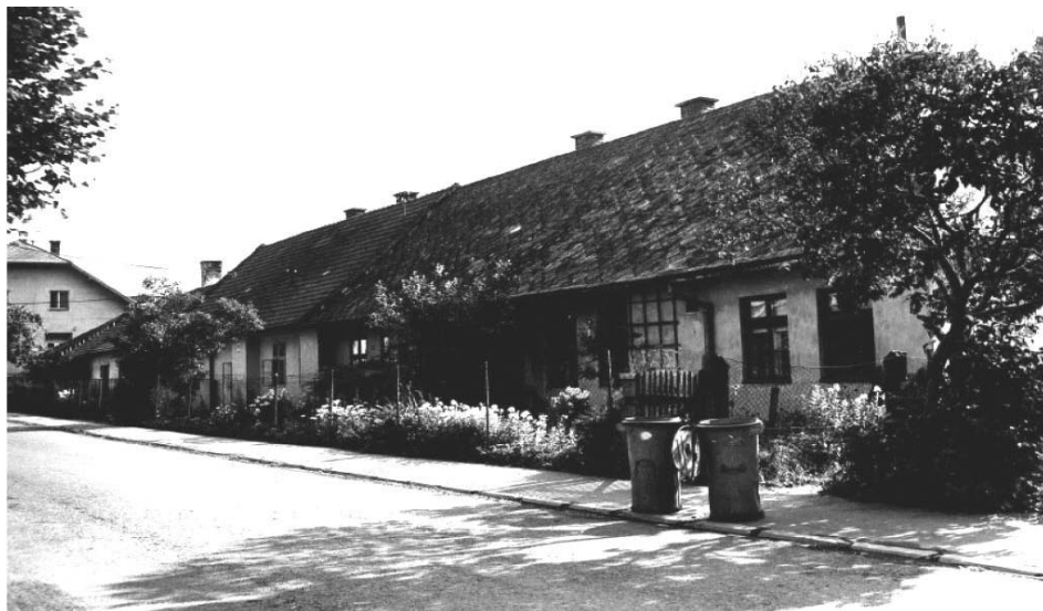
L. Hrádok – Prekážka pred asanáciou na začiatku 80. rokov 20. storočia
